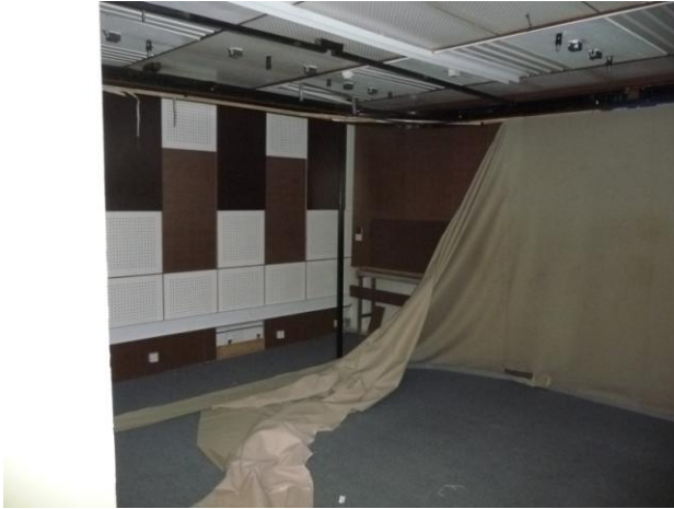
Bývalé TV štúdio na 3.N.P. v budove súp.č.1716
